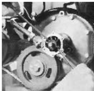
Bild G5 Demontering av pumphjul
